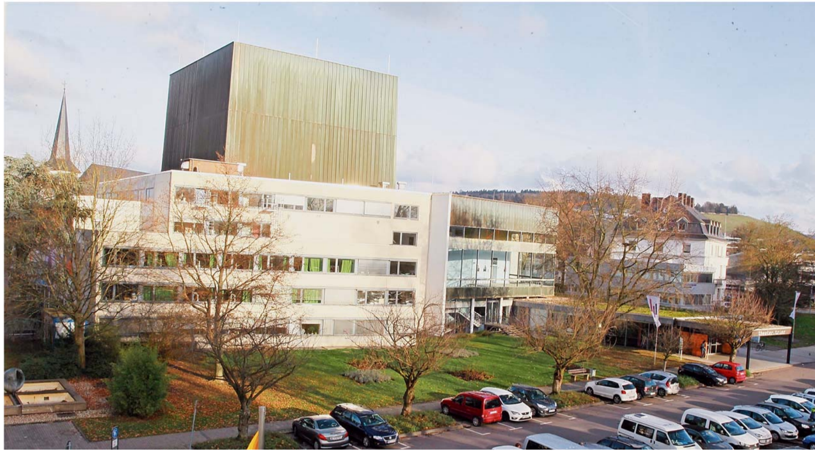
Das Stadttheater Trier wurde nach den Plänen des Architekten Gerhard Graubner gebaut. Muss das Gebäude unter Denkmalschutz gestellt werden? Die Grünen-Fraktion im Trierer Stadtrat hält das für notwendig. FOTO: FRIEDEMANN VETTER
