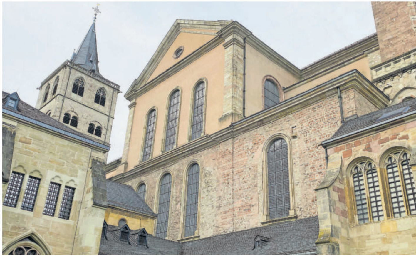
Der römische Teil des Trierer Doms mit seinen roten Sandsteinen ist vom Kreuzgang aus gut zu erkennen.
