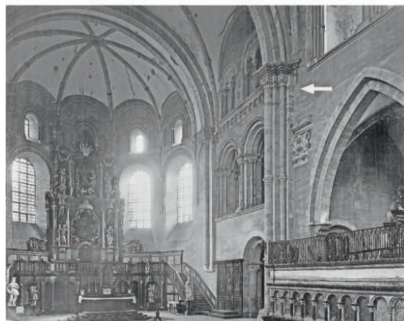
Blick in den Ostchor: Auf dieser historischen Aufnahme aus dem Trierer Dom im Jahr 1886 ist die Fundstelle des Rüstholzes markiert, die jetzt exakt datiert werden konnte.
